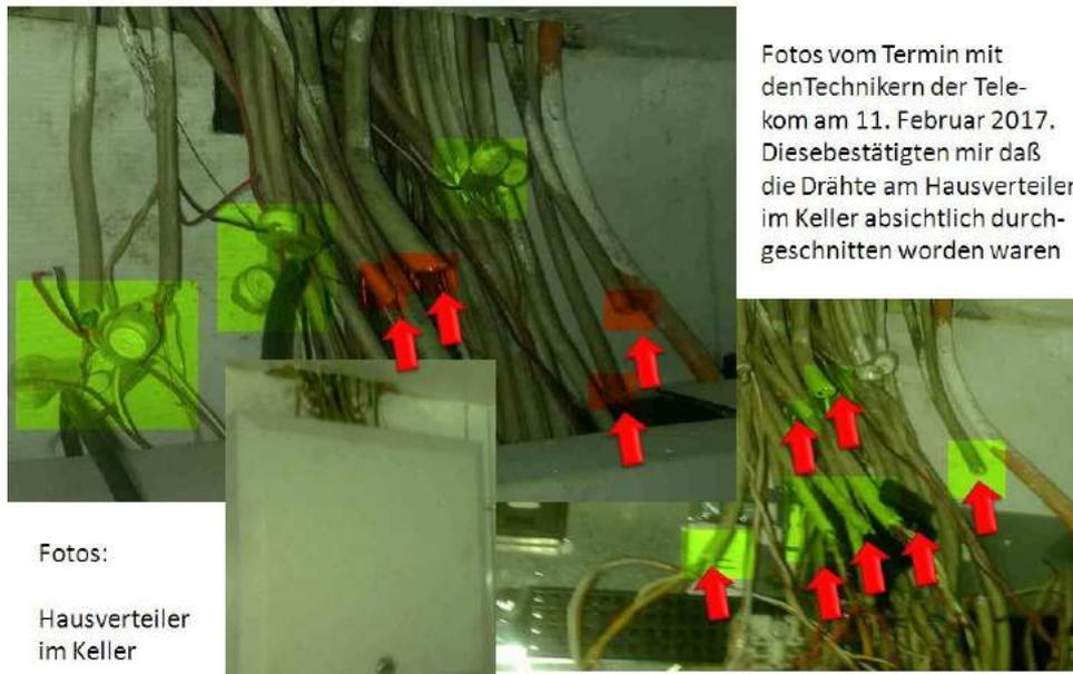
Fotos vom Termin mit den Technikern der Telekom am 11. Februar 2017. Diese bestätigten mir daß die Drähte am Hausverteiler im Keller absichtlich durchgeschnitten worden waren
